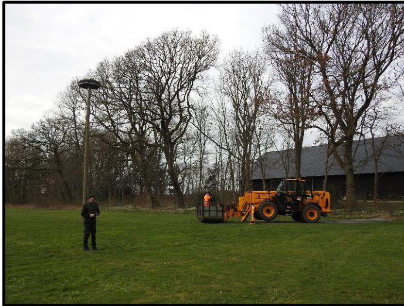
Rede renovering på Nr. Vosborg
